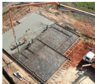
Betonfundamente „Laguna Rivera“
