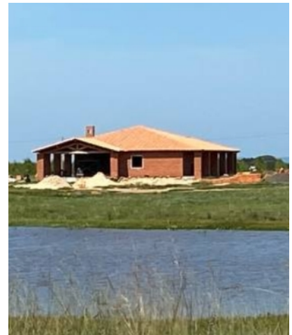
Hausbau in „Laguna Rivera“
