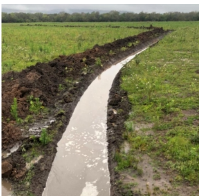
Kanalbau in San Salvador A
