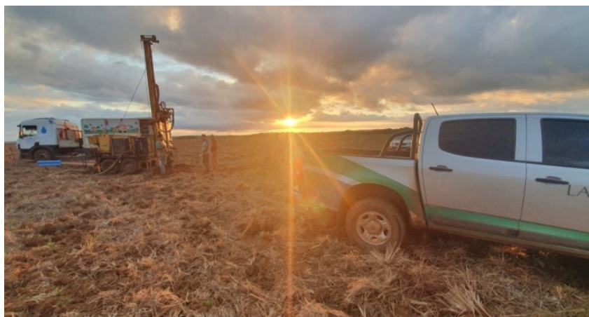
Bohrarbeiten für Tiefbrunnen
